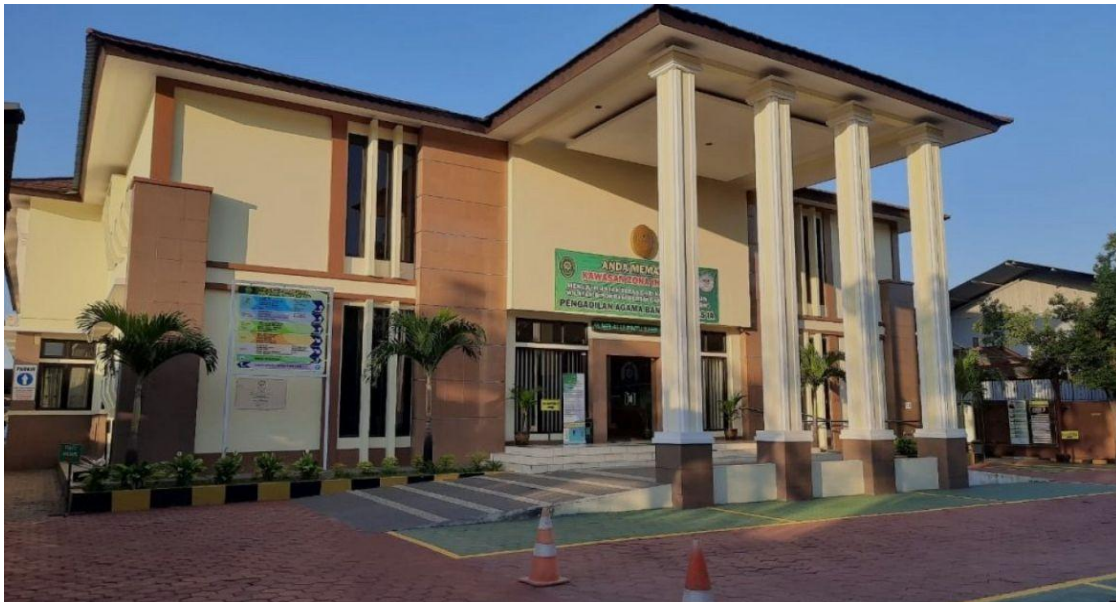
Gambar 4.3 Gedung Pengadilan Agama Bandung
