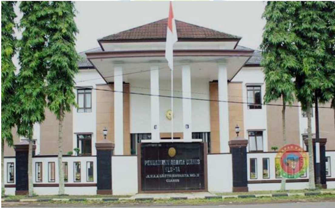
Gambar 4.14 Gedung Pengadilan Agama Ciamis
