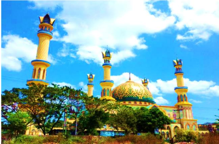
Gambar 7.7. Masjid Islamic Centre Kota Mataram (Sumber Foto : 30harikotakubercerita.poscinta )
