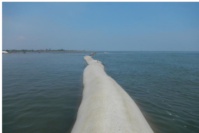
Gambar 2. Geotextile Tube Sebagai Submerge Break Water
