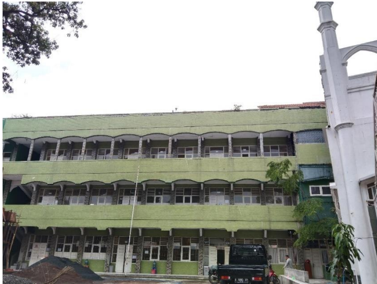
Kondisi Bangunan Yayasan Mathla'ul Anwar
