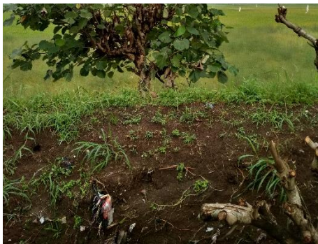
Terkikisnya pinggir sungai
